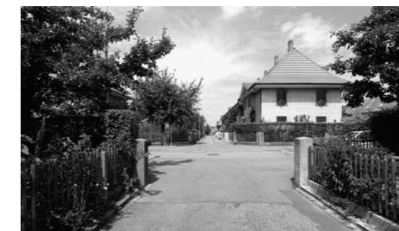
Siedlung Weissensteingut, Häuserzeile und Vorgarten
