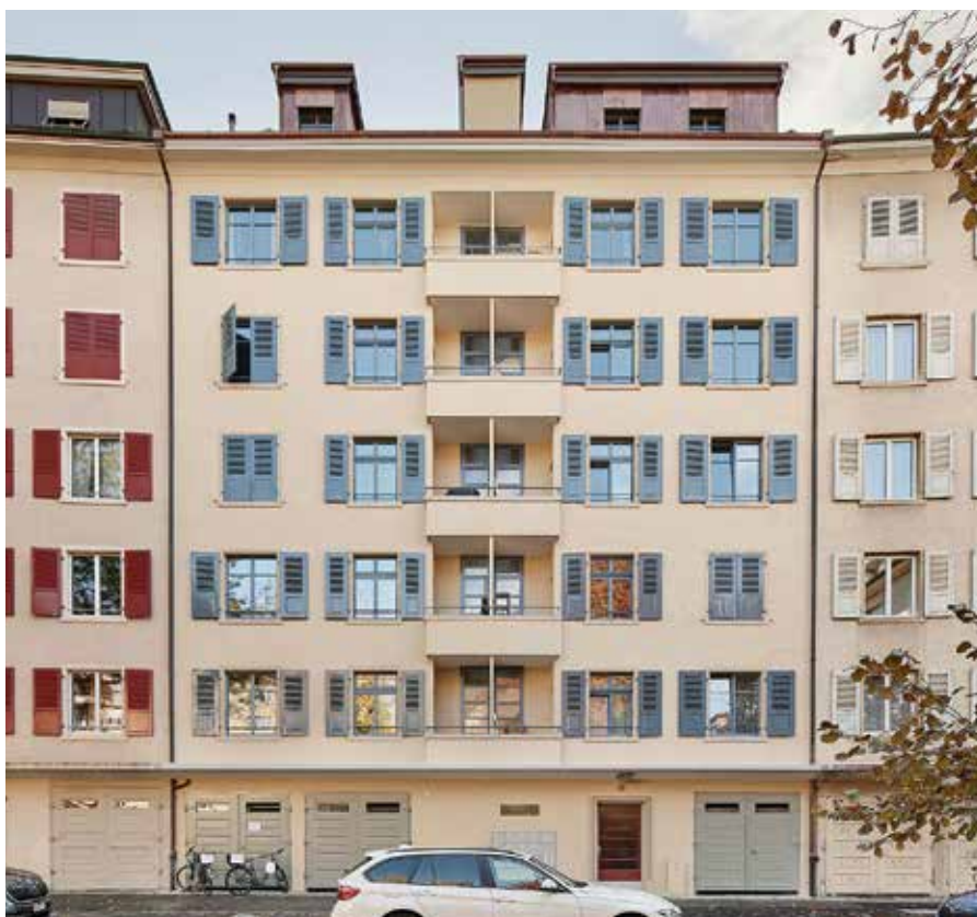
Aussenfassade Viktoriastrasse 40 mit zurückversetztem Sockel und wiederhergestellter Farbigkeit. Bild: Thomas Telley, 2020.
