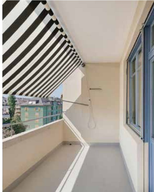
Balkon mit den nach Befund in Blau umfassten Fenstern in gelber Fassade. Bild: Thomas Telley, 2020.
